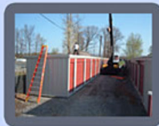
7 Unhook From Crane
